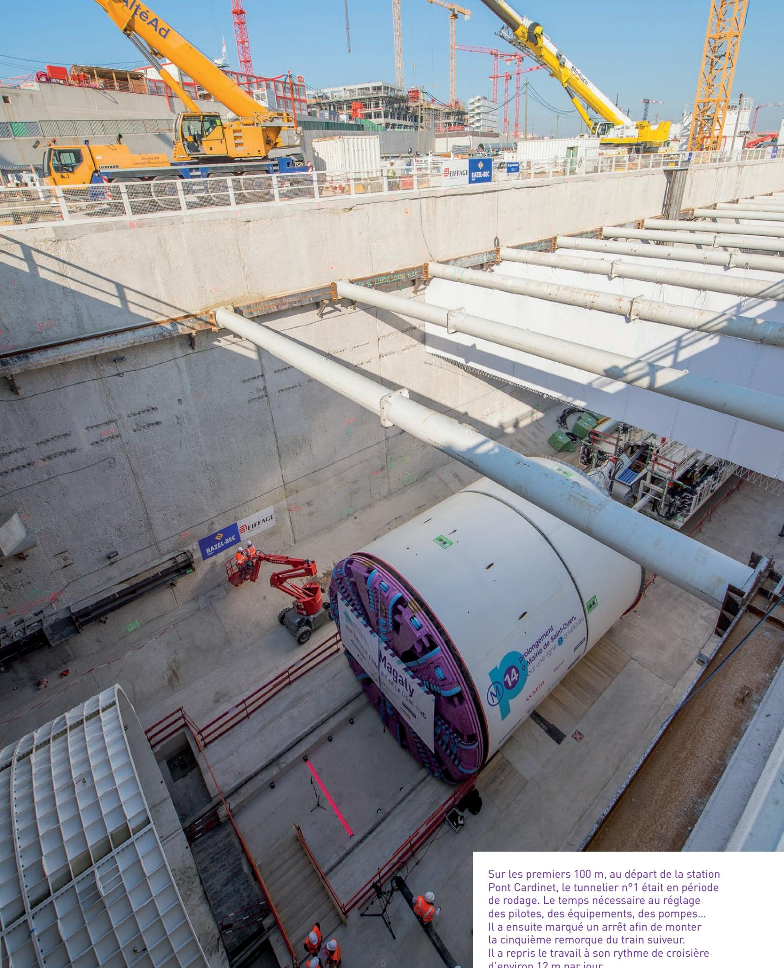
Sur les premiers 100 m, au départ de la station Pont Cardinet, le tunnelier n°1 était en période de rodage. Le temps nécessaire au réglage des pilotes, des équipements, des pompes... Il a ensuite marqué un arrêt afin de monter la cinquième remorque du train suiveur. Il a repris le travail à son rythme de croisière d'environ 12 m par jour.
